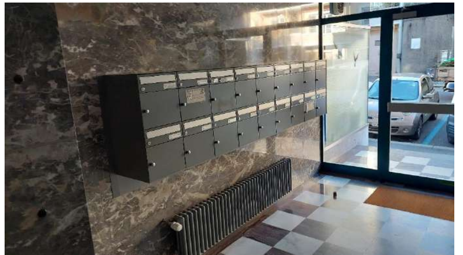
Hall d'entrée immeuble
