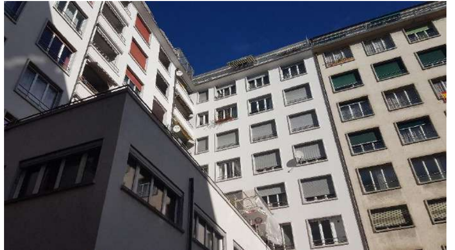
Façade sud (cour intérieure)
