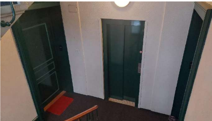
Cage d'escalier et ascenseur
