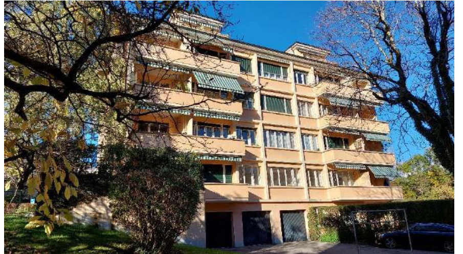
Façade sud et garages
