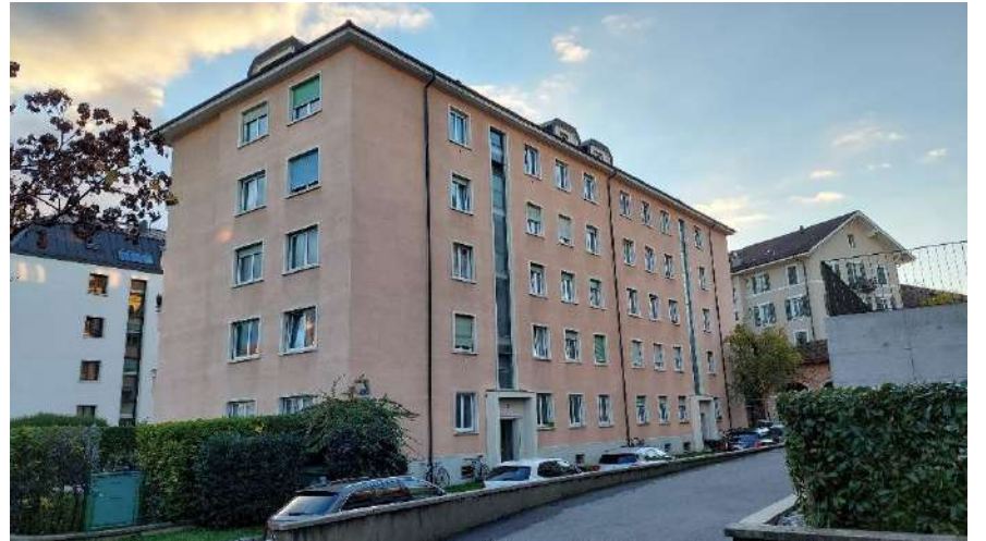
Façade nord et entrées
