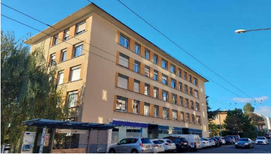
Façade nord-est et entrée
