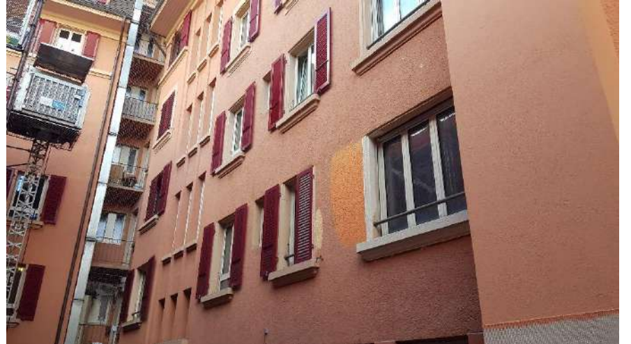
Façade côté cour intérieure
