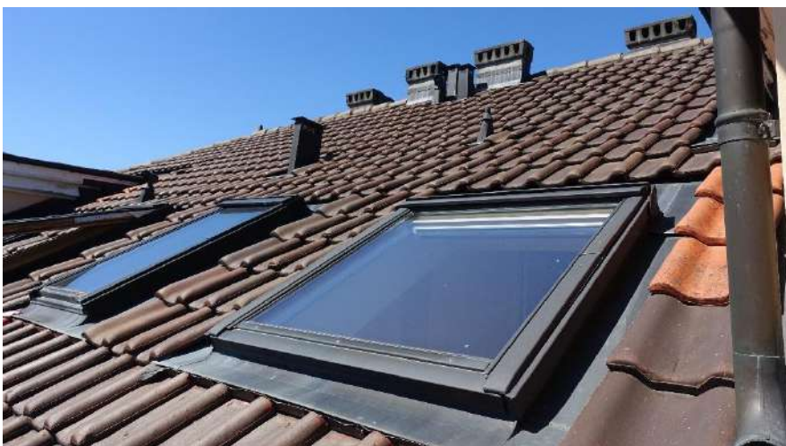
Toiture et velux
