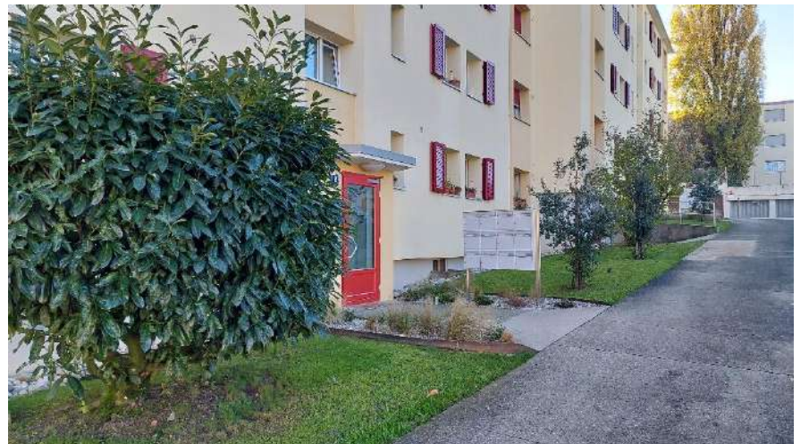
Entrée immeuble (Cassinette 2)
