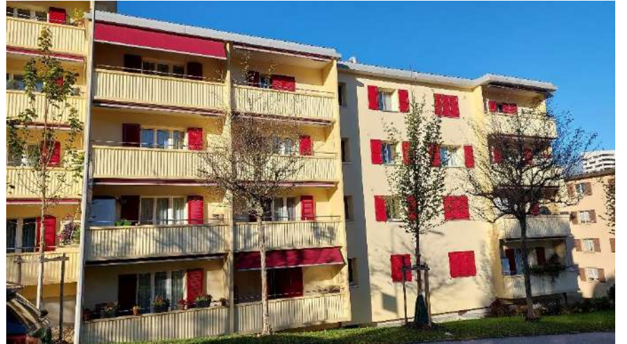
Façade sud (Cassinette 2)
