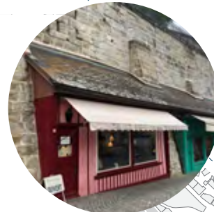
...un mur fermé qui est devenu actif. Place de la Riponne.
