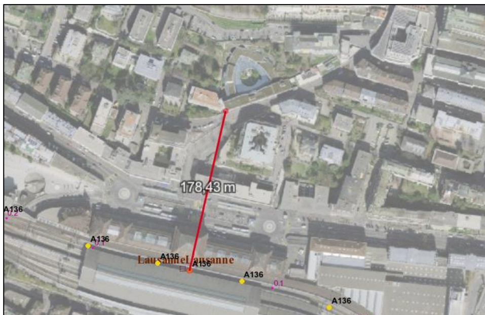
Figure 8-3 : Distance du projet par rapport aux voies CFF (source : www.screeningtgbahn.ch).
