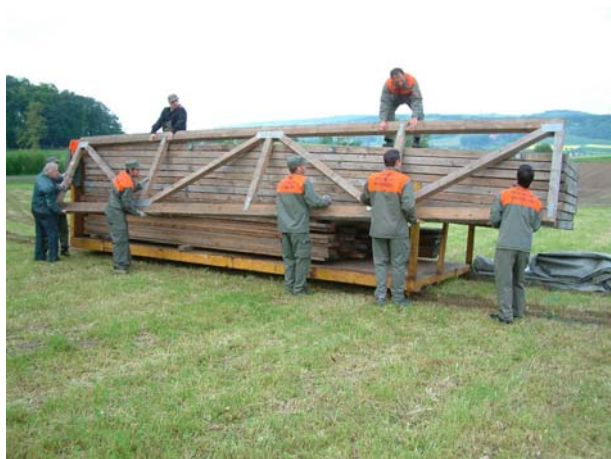
Aufbauarbeiten SOUND ARENA 2006
