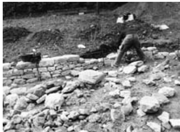
Bau der Trockensteinmauer beim Schulhaus bbz freiamt
