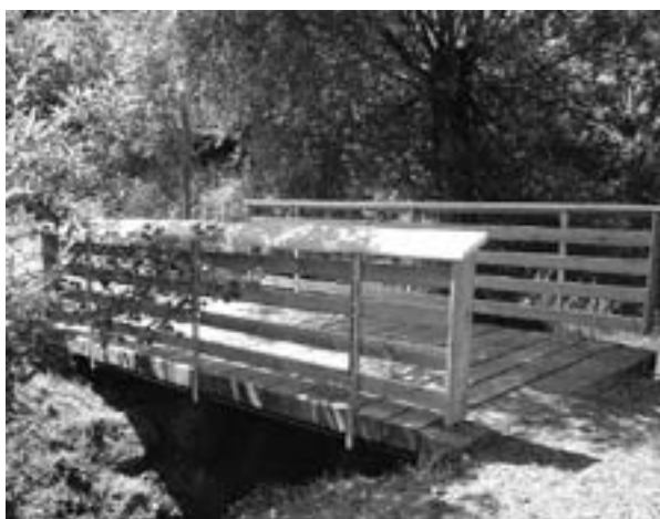
Anglikon, Erneuerung Holzbrücke Reservoirbach (DaG WABAKUM)
