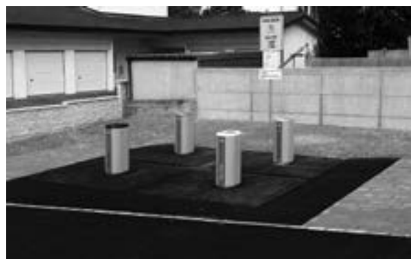
Neue Unterflur-Sammelstelle in Anglikon
