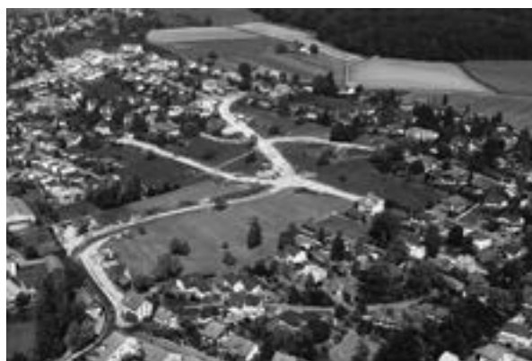
Sicht auf das Gebiet Rebberg mit den neuen Erschliessungsstrassen
