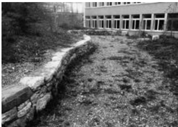
Neu erstellte Trockensteinmauer beim Schulhaus bbz freiamt
