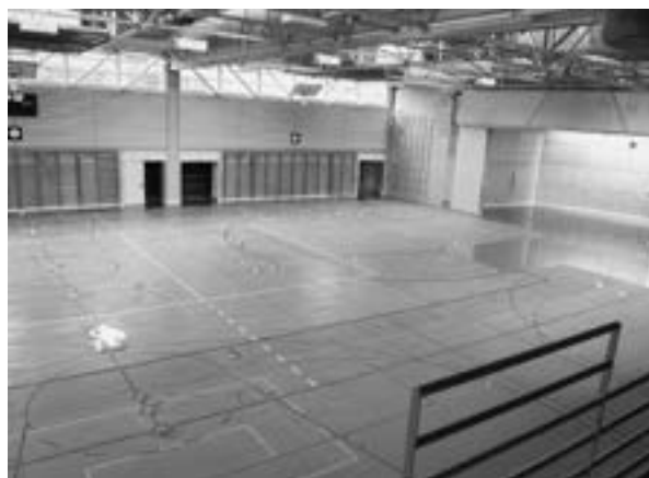
Blick in die Mehrfachturnhalle Hofmatten
