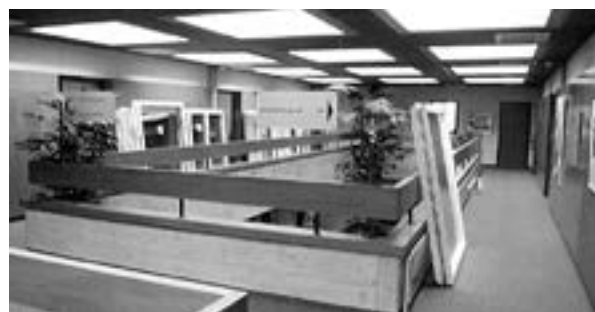
Gemeindehaus während der Sanierungsarbeiten
