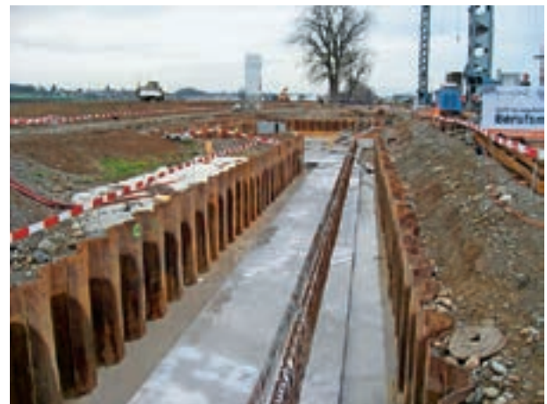
Fundation des Durchlassbauwerks
