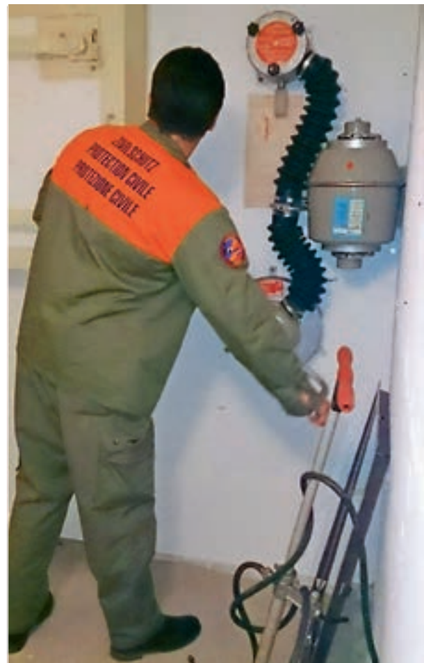
Funktionsprüfung des Lüftungsaggregates
