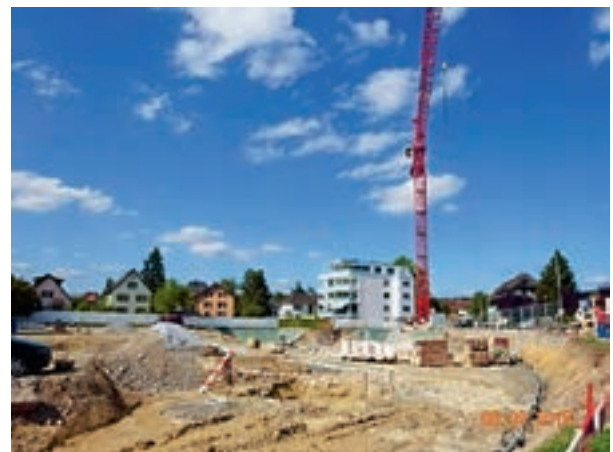
Baustelle Überbauung Steindlerstrasse
