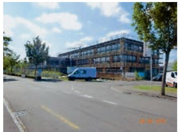
Baustelle Neubau Intergra Freiamt
