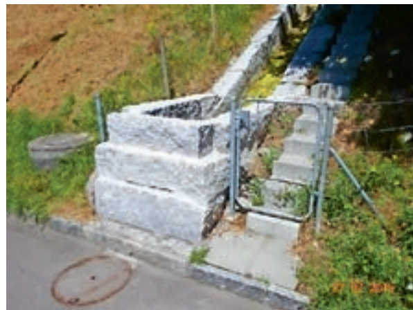
Ergänzende Hochwasserverbauung Reservoirbach bei der Knobelstrasse
