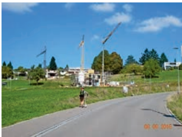
Baustelle Einfamilienhaus Rebberg
