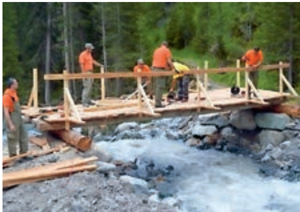
Neubau Brücke im Val Plavna
