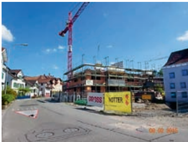
Baustelle Mehrfamilienhaus Steingasse
