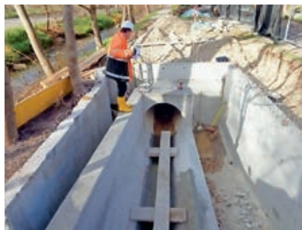
Umbau am Schachtbauwerk im Areal der Kantonsschule
