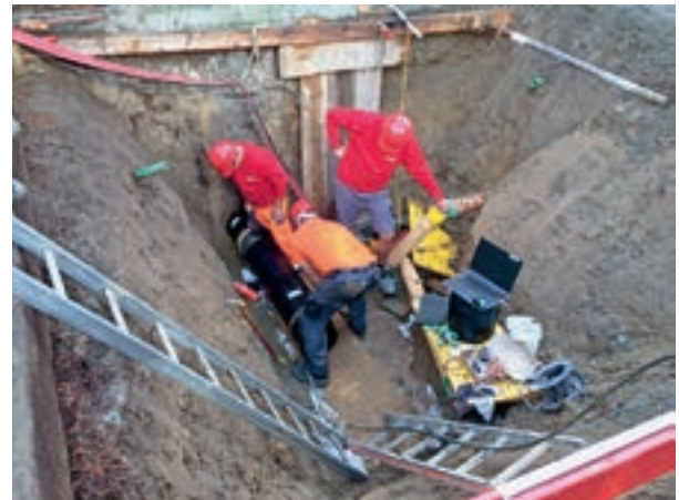
Baugrube für das Berstliningverfahren mit Überwachung der zulässigen Zugkräfte
