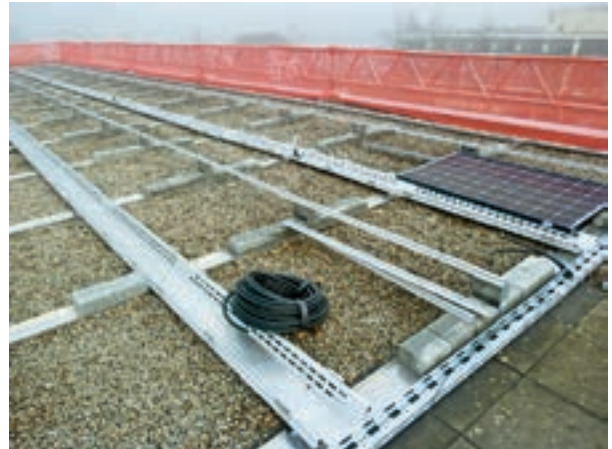
Baustelle der neuen Photovoltaik-Anlage auf dem Dach des Gemeindehauses
