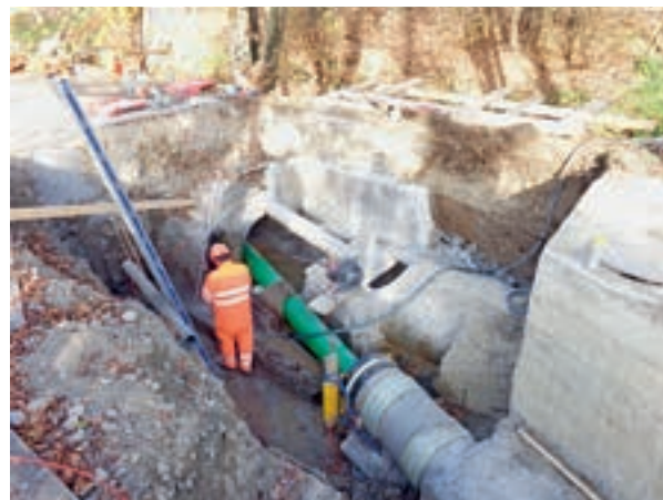
Umbau am Schachtbauwerk beim Schwimmbad
