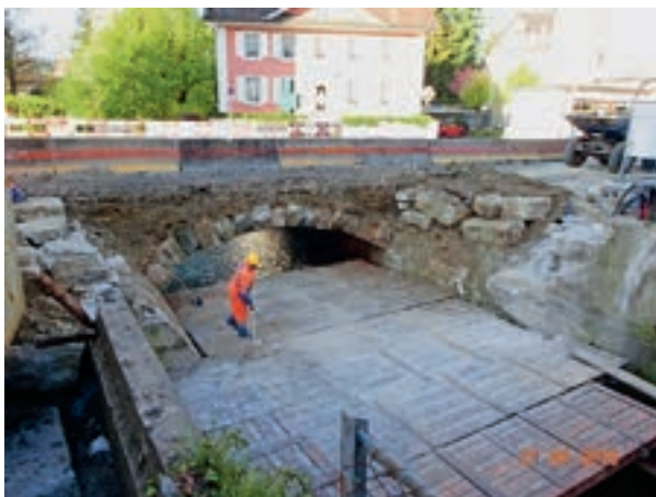
Halbseitig abgebrochene Brücke Zentralstrasse
