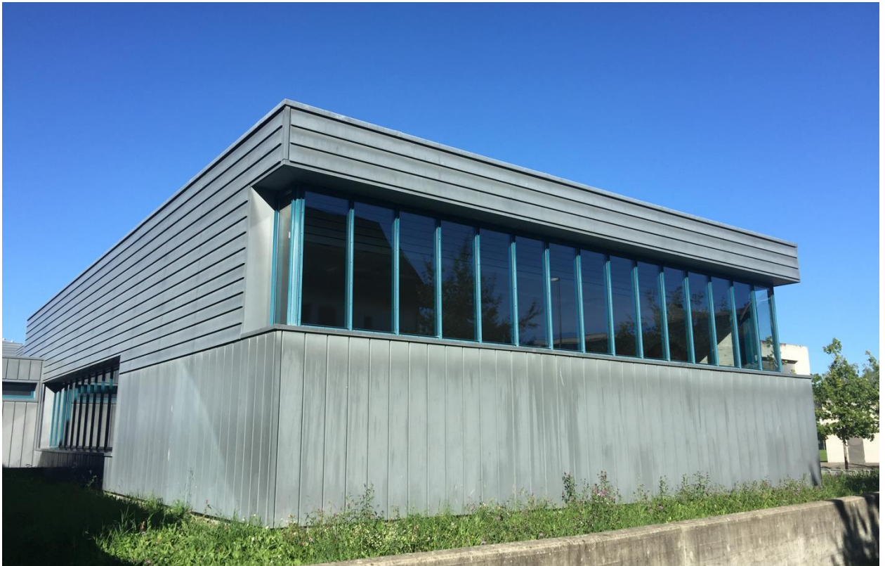
Aussenansicht Lehrschwimmbecken Bünzmatt
