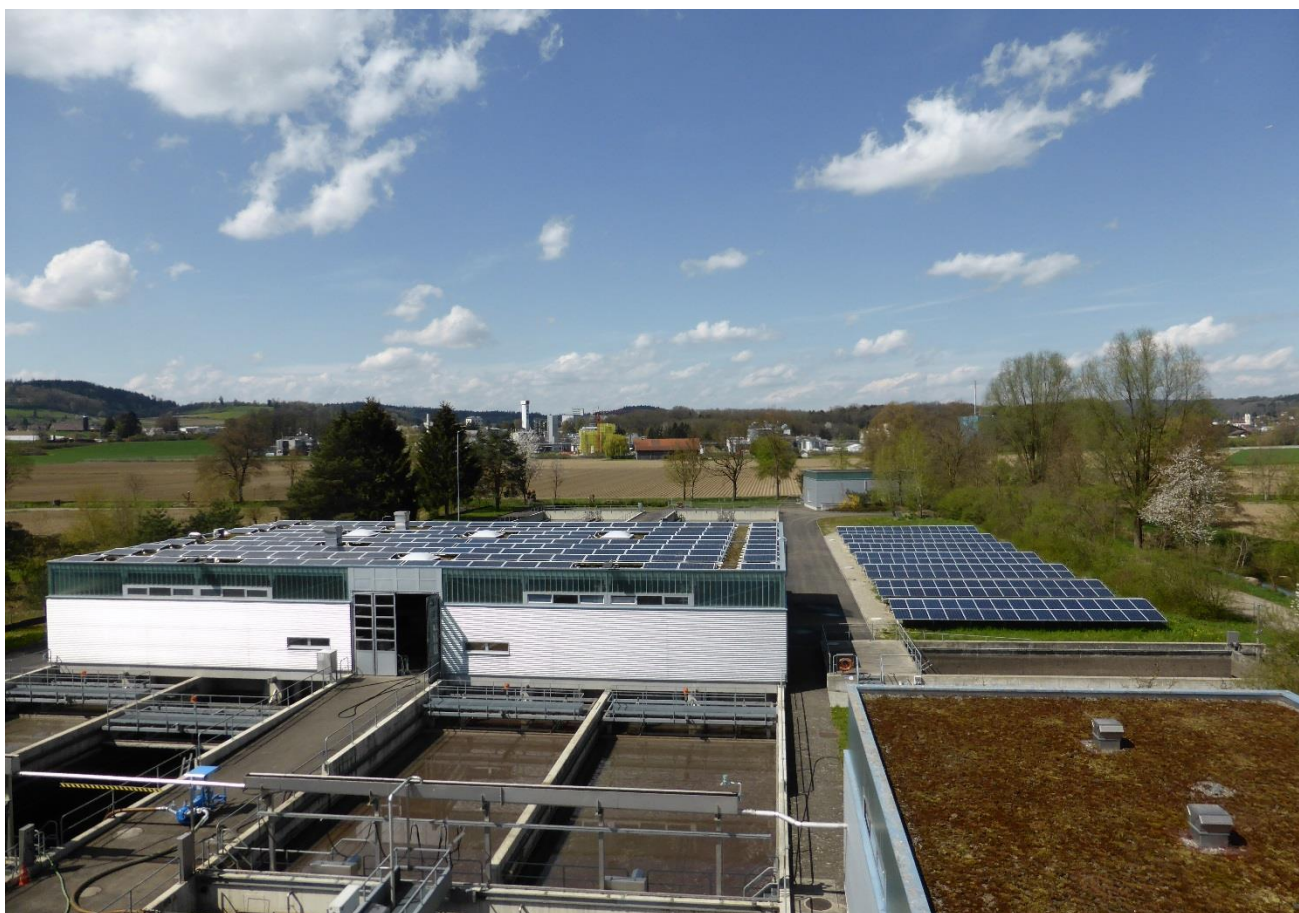
Blick auf die gesamte Photovoltaikanlage
