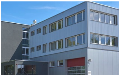
Beispiel Loepfe Brothers, Wetzikon (ZH) Mit Holzelementbau aufstocken
