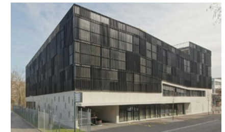
Beispiel Sika-Infrastrukturzentrum, Zürich (ZH) Gewerbeneubau mit Parkhaus in den Obergeschossen, welcher optional auf 25 m aufgestockt werden kann
