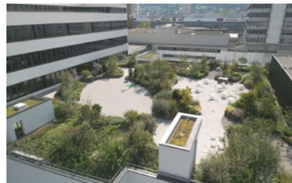
Beispiel Ecopark, Spreitenbach (AG) Dachterrasse mit Dachbegrünung
