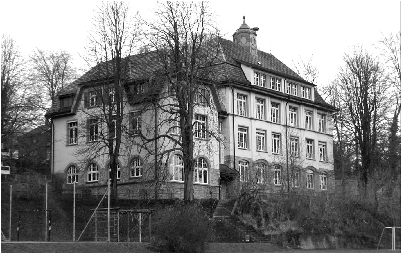
Lessingstrasse 46, Schulhaus Gerhalde, Innensanierung und Neubau Turnhalle
