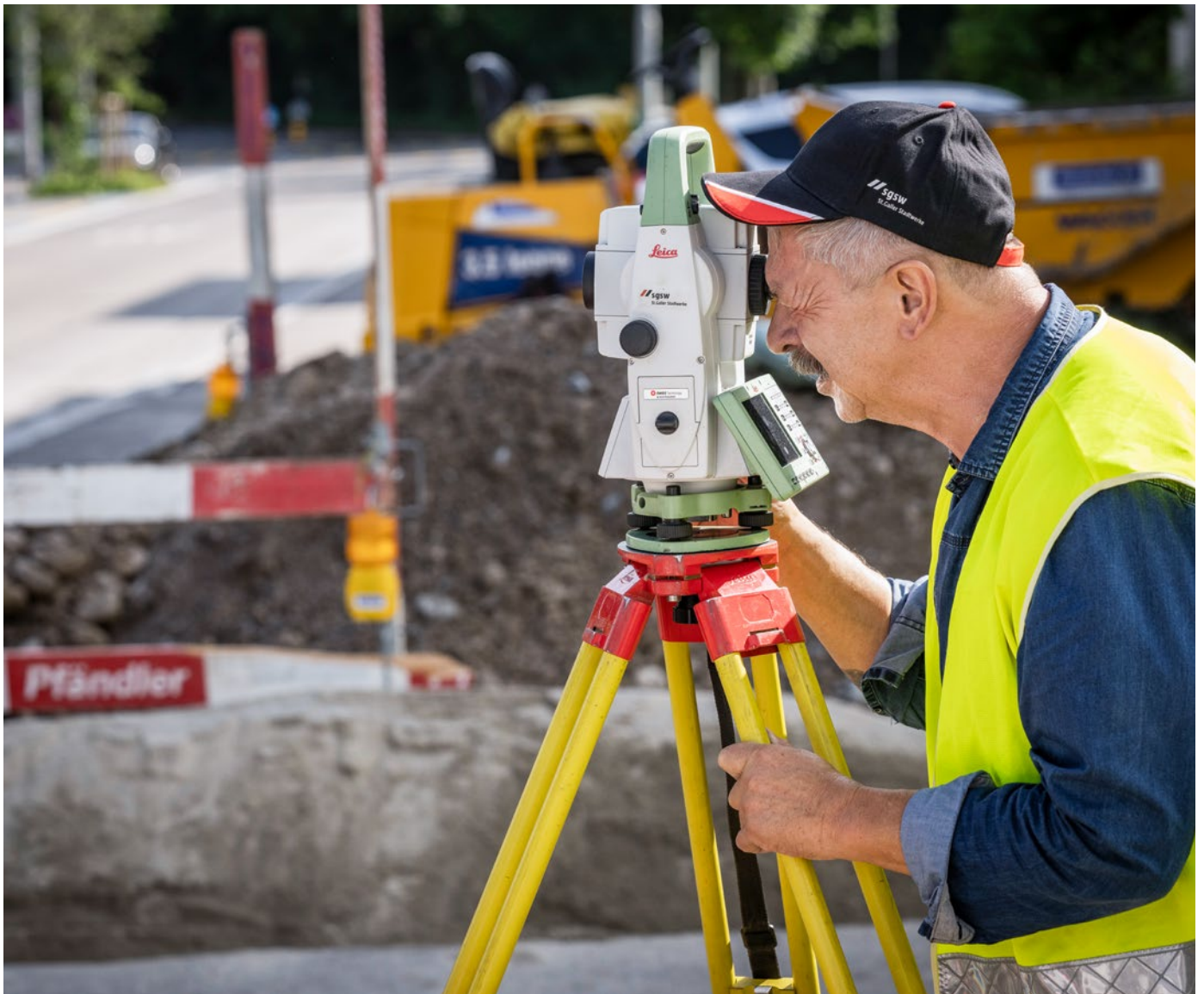
↑ Einmesser Karl Grubenmann misst Punkte einer Werkleitung ein, sodass diese später im Geoinformationssystem dargestellt werden kann.
