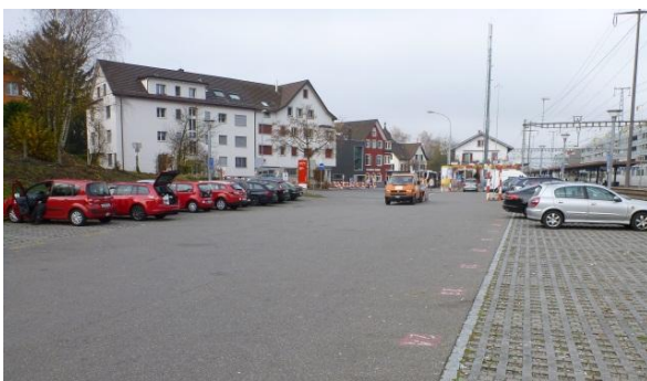
Abbildung 15: grosszügig dimensionierte P&R-Anlage östlich des Bahnhofgebäudes
