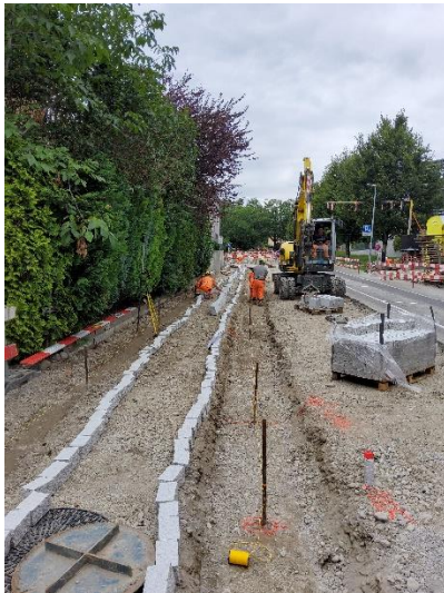
Absteckung für Randabschlüsse
