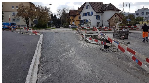
Randabschlüsse, Fussgängerschutzinseln, Tragschichten
