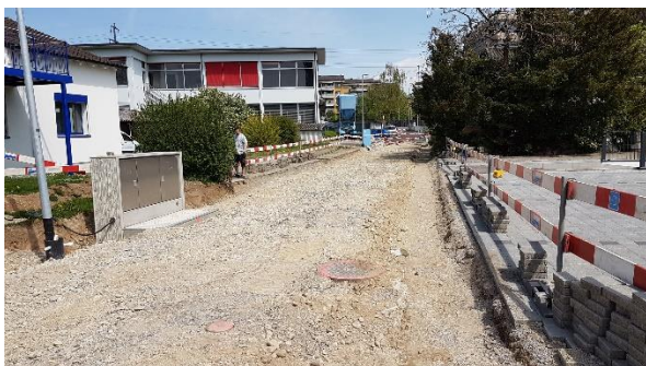
Strassenfundation und Verteilkabine für Strom
