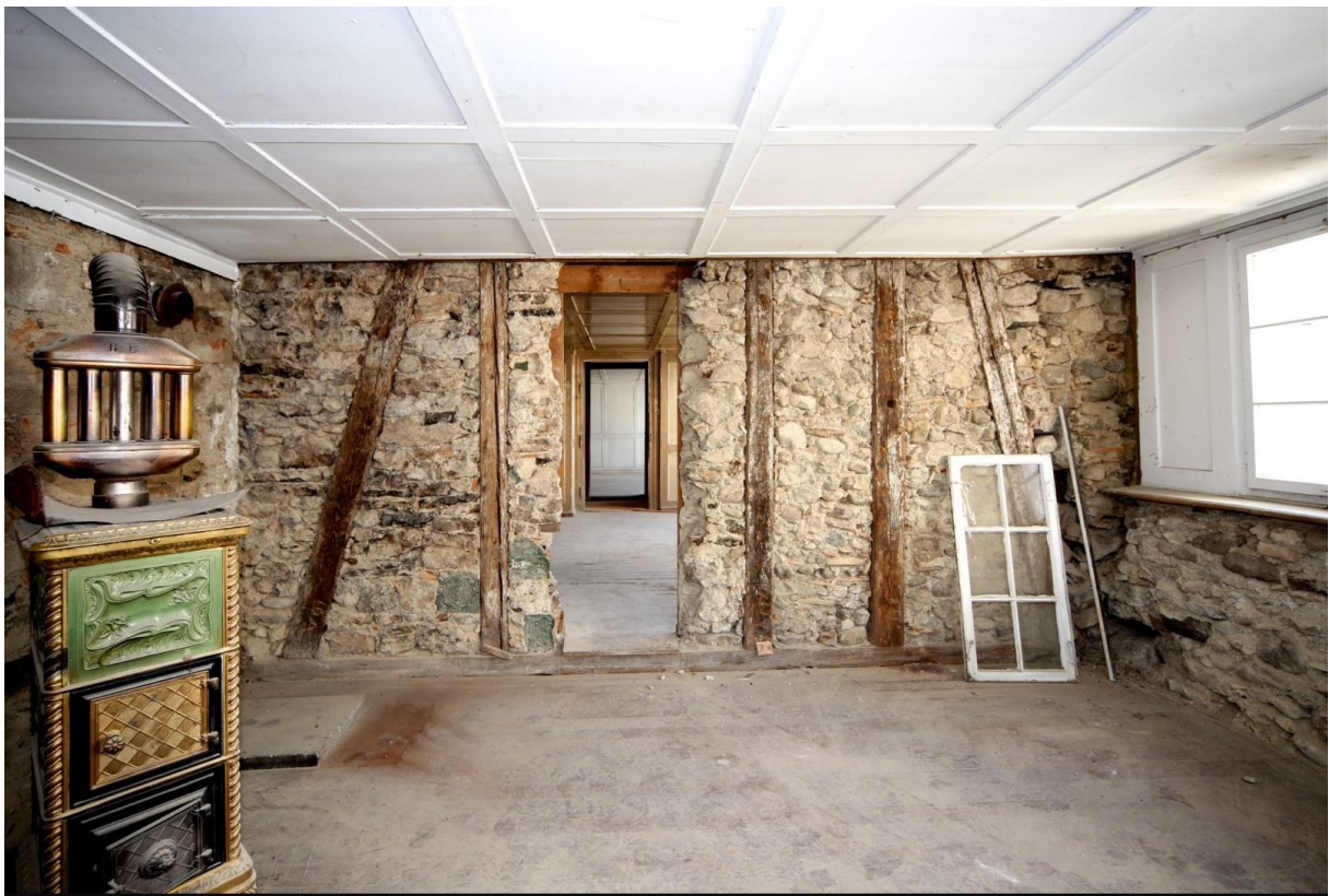
Projekt Tulpenstrasse Baufeld B, Projektleitung: C. Vanoli Generalunternehmung AG, Bauherrschaft Ant. Bonomo's Erben Immobilien AG; Umbau denkmalgeschützte Liegenschaft an der Wallisellenstrasse 31-41: Das denkmalpflegerisch sehr anspruchsvolle Bauvorhaben des im Kernbau auf das 15. Jh. zurückgehenden Gebäudes konnte dank vorbildlich enger Zusammenarbeit und regem Austausch aller beteiligten Stellen so ausgearbeitet und dokumentiert werden, dass nach Vorbereitungs- und Sondagearbeiten per Ende 1. Quartal 2022 der Baubeginn erfolgen kann.
