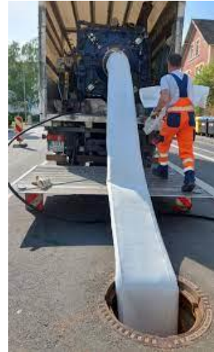
Einzug von Schlauch (Inliner)
