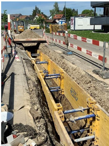
Gespriesster Graben für die Kanalisation
