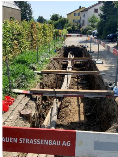
Grabenbau für Elektrorohre
