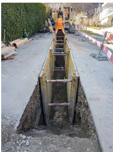
Werkleitungsgraben gespiesst
