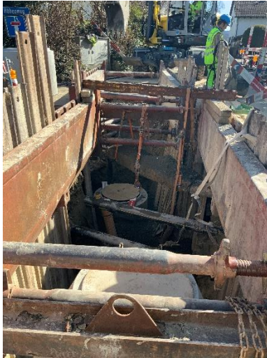
Gespriesster Graben für Kanalisation
