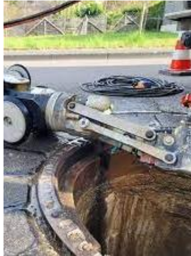
Roboter für Innensanierung
